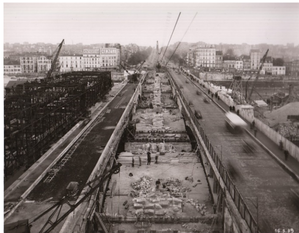
Reconstruction du Pont de Neuilly – mai 1939 A.M.N.S.S.6Z1.
