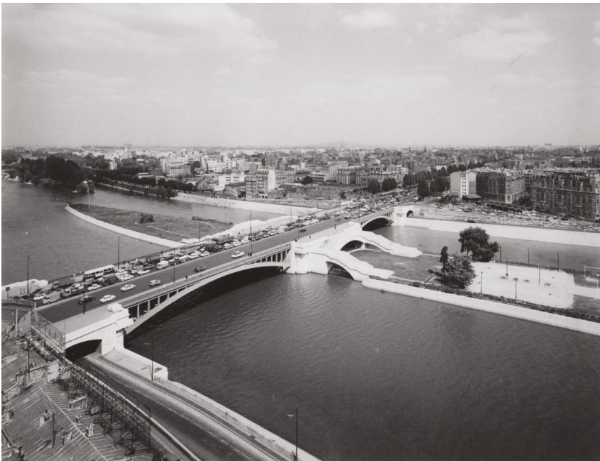
Le pont d'acier en 1962 5 Fi 3.14, A.M.N.S.S.
