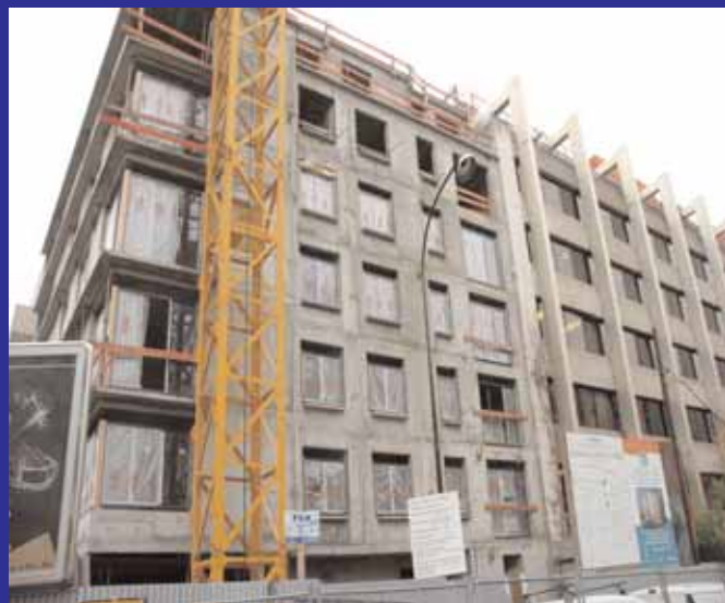
22 logements sociaux, un commerce et un parc de stationnement en construction à l'angle des rues Dupont et Iby
